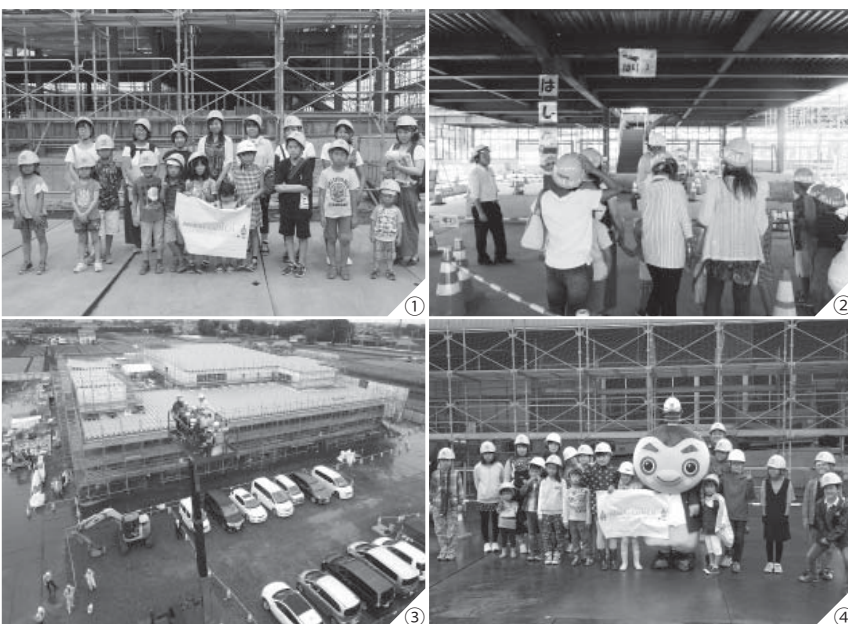
①：8月23日に見学した皆さん ②：建設中の給食センター内部で説明を聞く参加者 ③：高所作業車で給食センターを上から眺める参加者 ④10月14日に見学した皆さん
