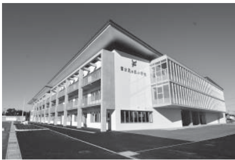
完成した富士見ヶ丘小学校
