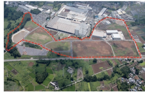
造成工事が進められている福岡工業団地土地地区画整理事業
