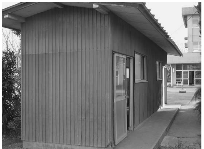
板橋小学校の屋外トイレ
