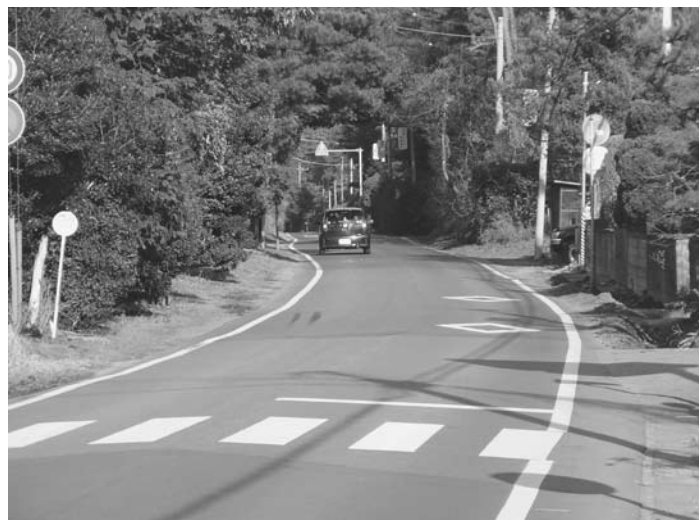
主要地方道つくば野田線 (出山住宅付近)
