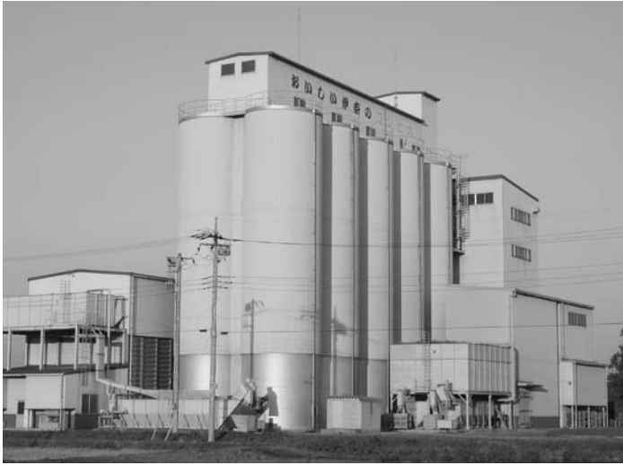
カントリーエレベーター
