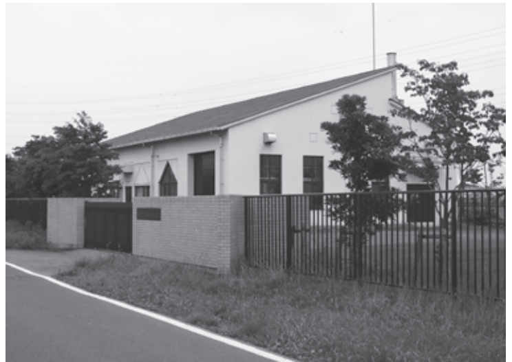
十和地区農業集落排水処理施設
