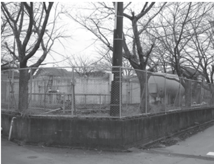
小絹浄水場 (西ノ台地区浄水場)
