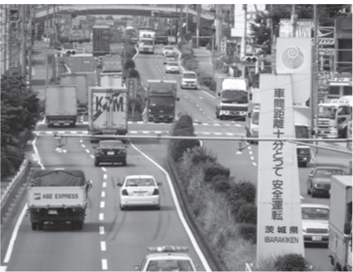
国道294号（谷和原 IC 付近）
