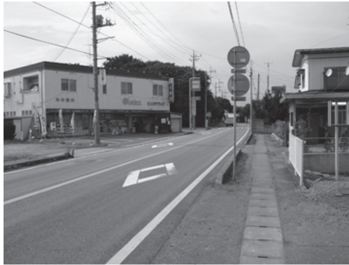
主要地方道取手つくば線（谷井田付近）
