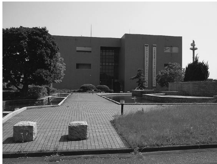
取手地方広域下水道組合 (取手市小文間)
