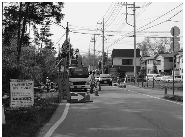
下水道工事 (愛高団地付近)
