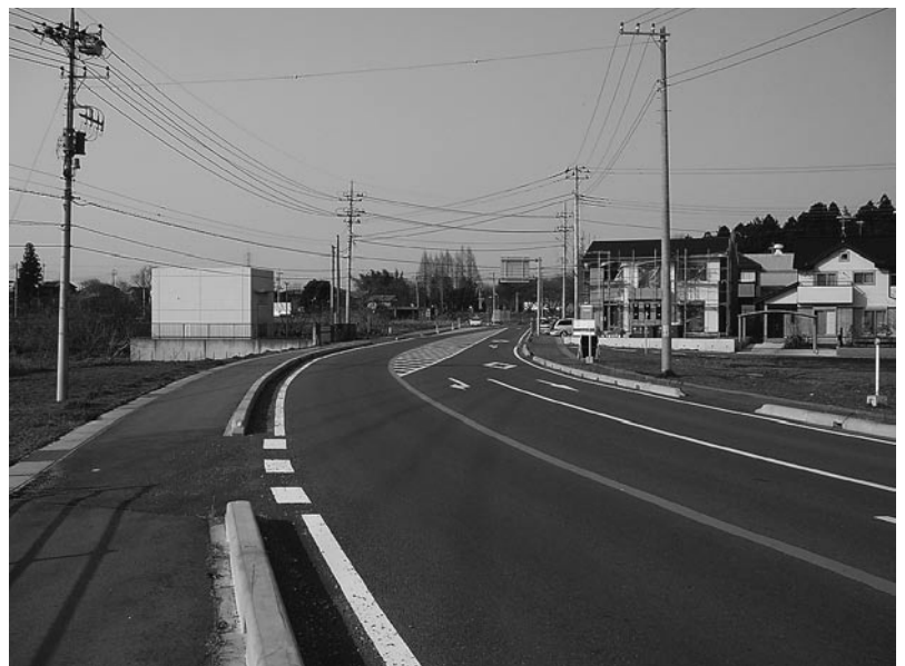
守谷小絹線 (筒戸付近)
