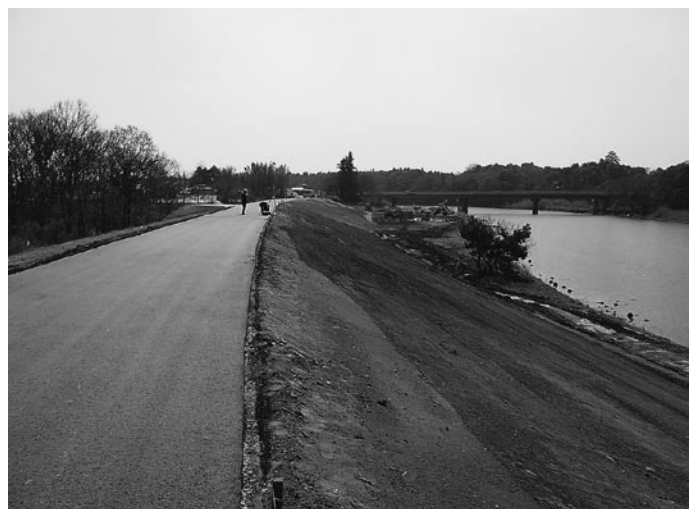
小貝川堤防等工事（青木付近）
