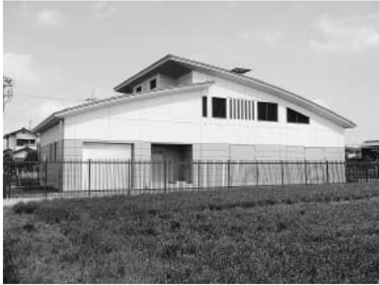
山王新田汚水中継ポンプ場
