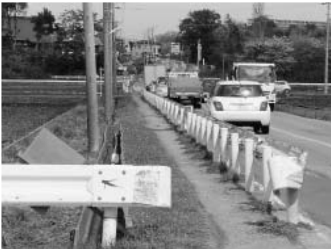
県道つくば野田線（黎明付近）
