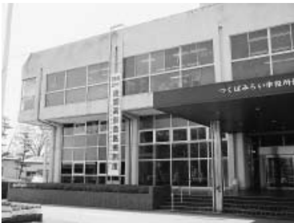
市役所伊奈庁舎
