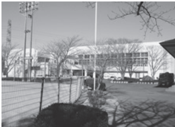
総合運動公園体育館（板橋）
