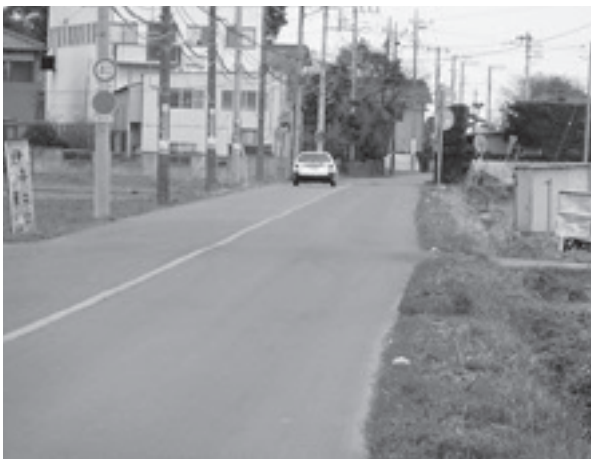
主要地方道取手つくば線(伊奈地区交番前から五反田方面を望む)
