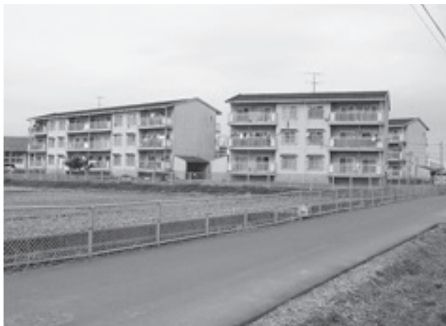
市営古川住宅
