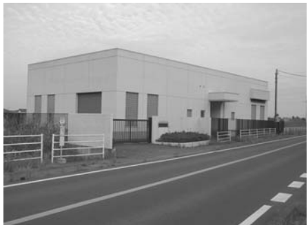
取手地方広域下水道組合「福田汚水中継ポンプ場」(福田)
