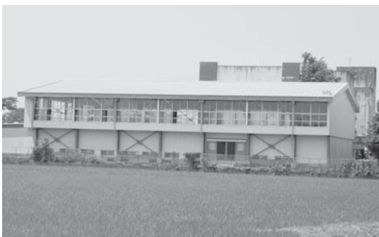
避難所に指定されている三島小学校屋内運動場
