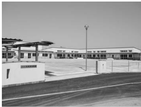
下小目に建設中の谷和原幼稚園・谷和原第2保育所
