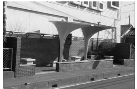
昭和 57 年に設置された谷井田小学校沿道の「ふれあいの場」
