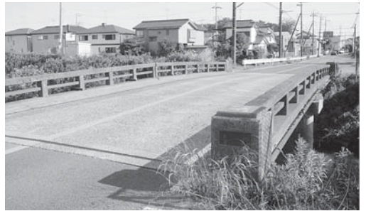
中通川に架かる谷井田大橋
