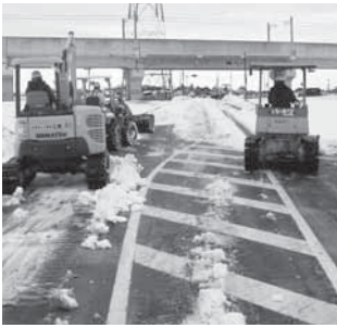
除雪作業の様子（青木地先）
