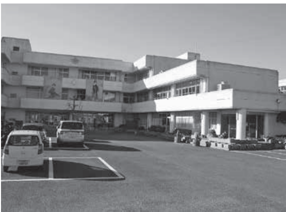
大規模改修工事を行う伊奈東中学校舎
