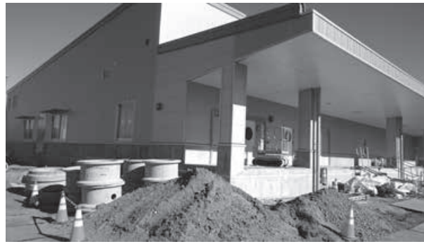
建設が進められている学校給食センター
