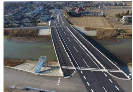
▲取手つくば線バイパス谷井田大橋
