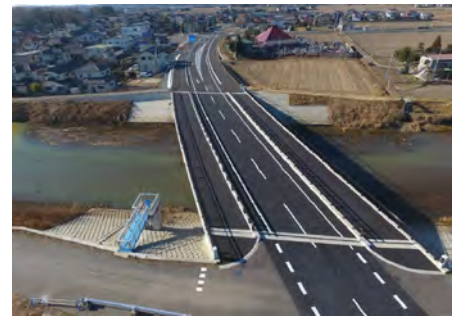
▲取手つくば線バイパス谷井田大橋
