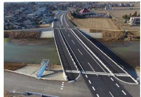
▲取手つくば線バイパス谷井田大橋
