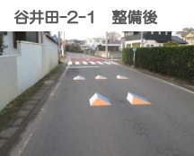
谷井田-2-1 整備後
