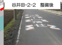
谷井田-2-2 整備後
