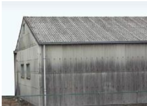
石綿含有スレート波板（屋根・外壁）
