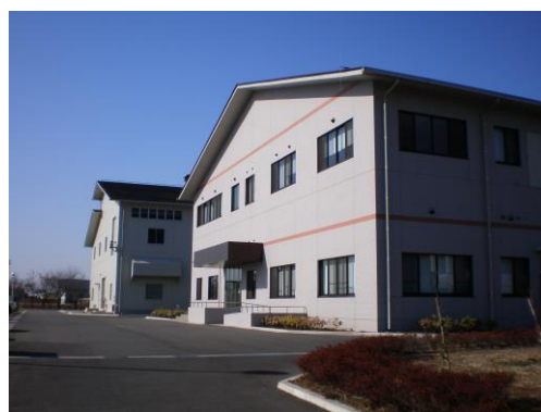
図 4.4.1 小絹水処理センター
