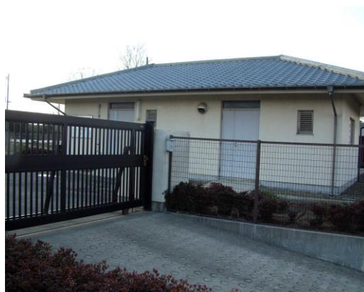
図 4.4.2 上平柳地区農業集落排水処理施設
