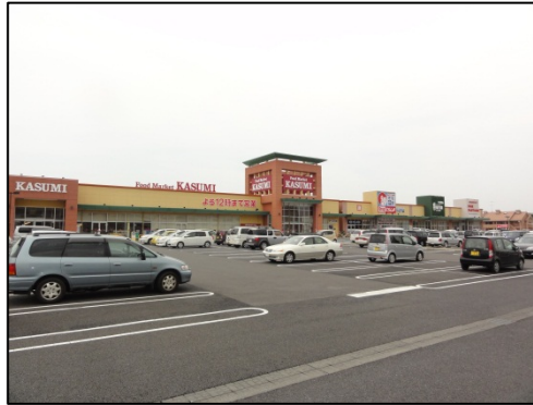
大型商業施設
