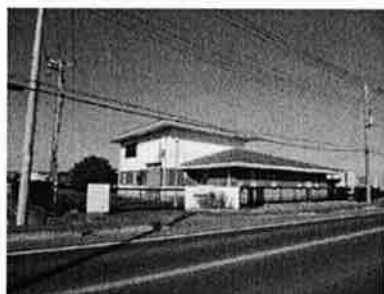
上小目中継ポンプ場
