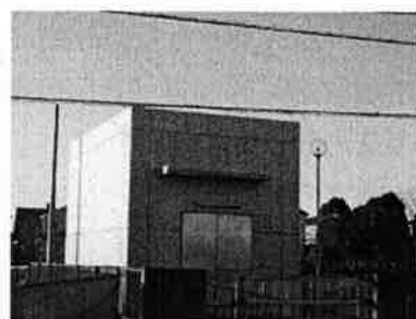
内宿中継ポンプ場
