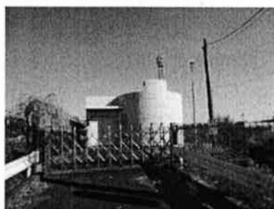
高掛中継ポンプ場
