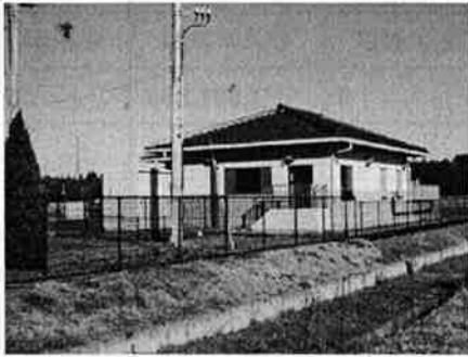
高岡狸穴処理場
