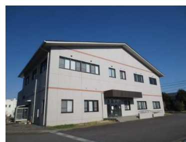
小絹水処理センター管理棟
