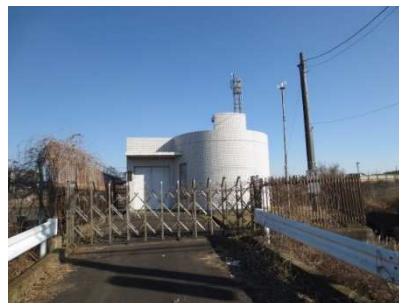
高掛中継ポンプ場
