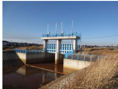
蛇沼排水路樋管
