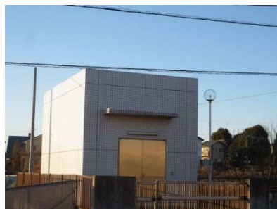
内宿中継ポンプ場
