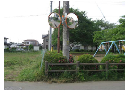
カーブミラー設置状況
