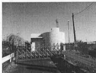
高掛中継ポンプ場
