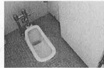
改修前のトイレ
