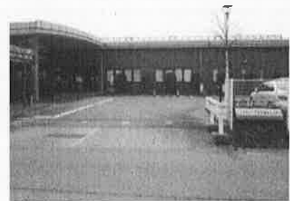
保健福祉センターの外観
