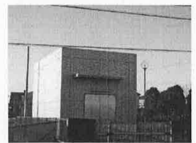
内宿中継ポンプ場
