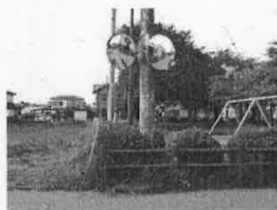
カーブミラー設置状況
