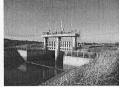
蛇沼排水路樋管
