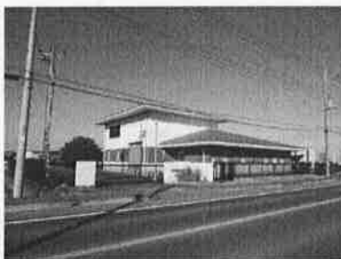
上小目中継ポンプ場
