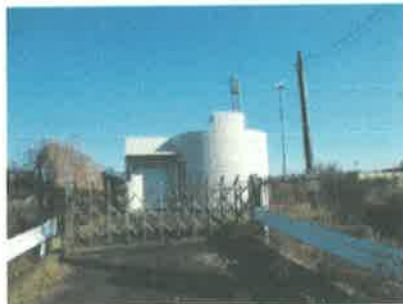
高掛中継ポンプ場
