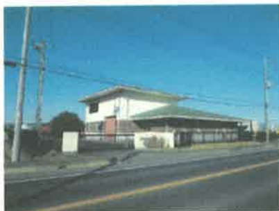
上小目中継ポンプ場
