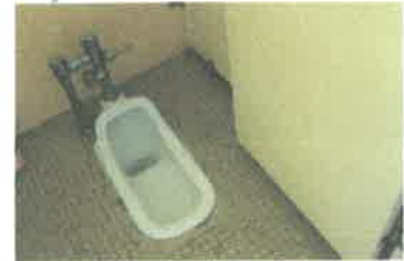
改修前のトイレ
