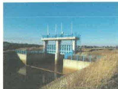
蛇沼排水路樋管
