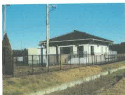
高岡狸穴処理場
