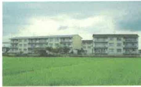
公営古川住宅
