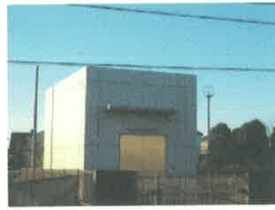
内宿中継ポンプ場
