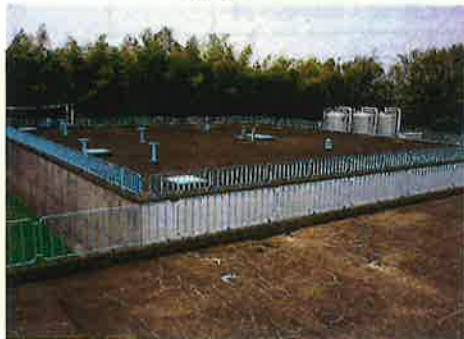
《旧施設》 (久保浄水場 高区配水池)
