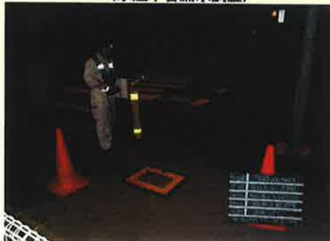
《作業状況》 (水道本管漏水調査)
