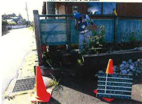
《作業状況》 (給水管漏水調査)
