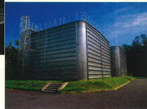
《送水先のみらい平配水場 配水池》
