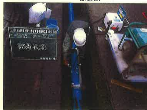
《施工中》 (ポリエチレン管融着)
