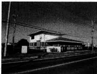
上小目中継ポンプ場
