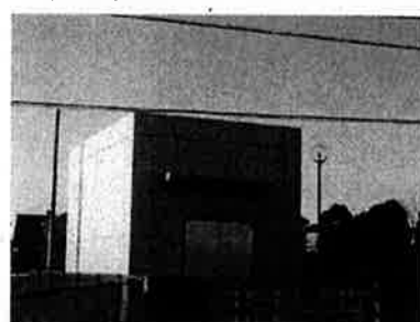
内宿中継ポンプ場
