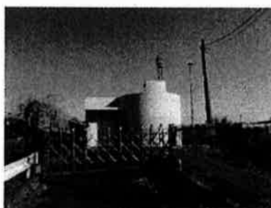
高掛中継ポンプ場
