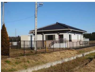
高岡狸穴処理場
