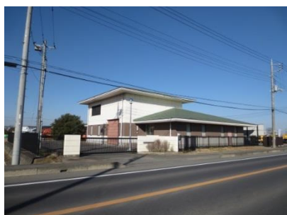
上小目中継ポンプ場
