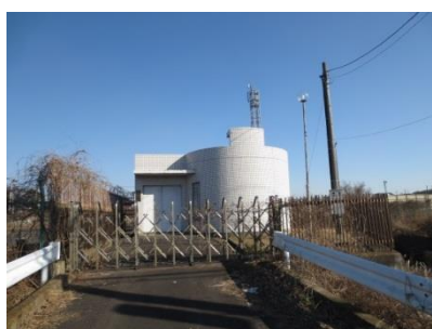
高掛中継ポンプ場
