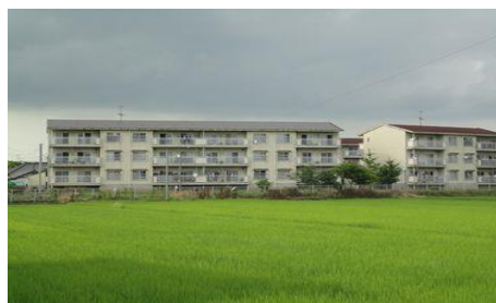
公営古川住宅
