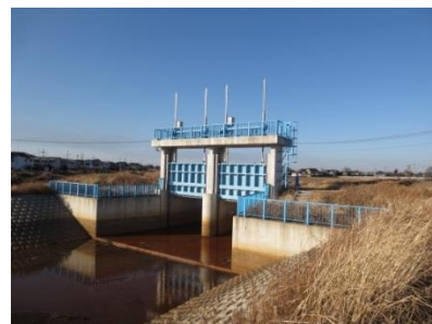
蛇沼排水路樋管
