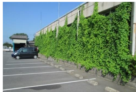
市役所（谷和原庁舎）で実施したグリーンカーテンの様子
