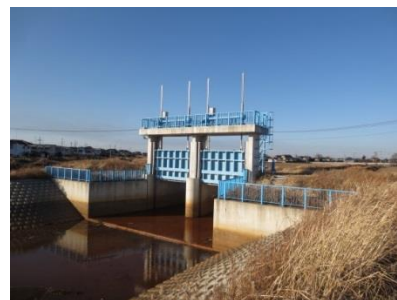
蛇沼排水路樋管
