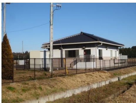
高岡狸穴処理場
