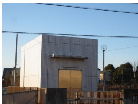
内宿中継ポンプ場
