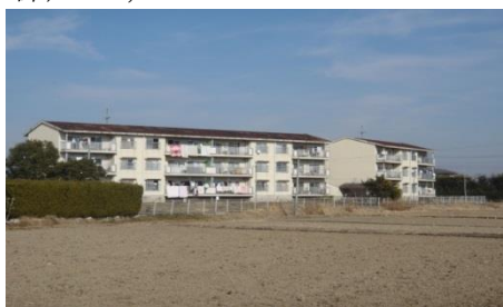
公営古川住宅
