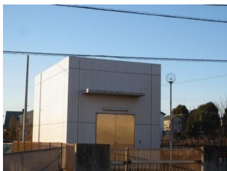
内宿中継ポンプ場
