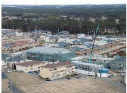
陽光台小学校建設風景
