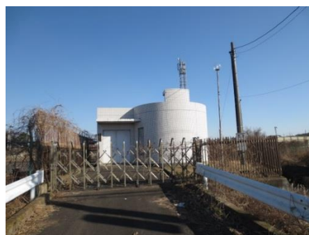
高掛中継ポンプ場
