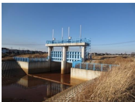
蛇沼排水路樋管
