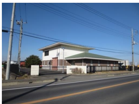
上小目中継ポンプ場
