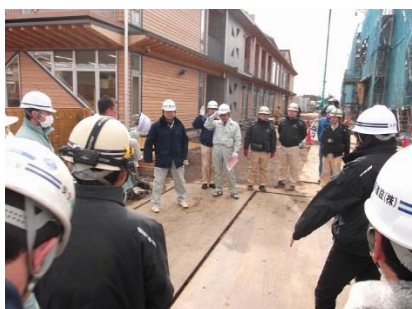
陽光台小学校校舎建設工事の完了検査風景
