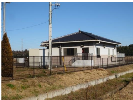
高岡狸穴処理場
