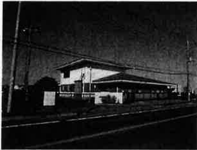
上小目中継ポンプ場
