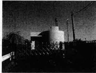
高掛中継ポンプ場
