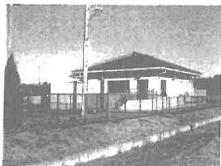
高岡狸穴処理場
