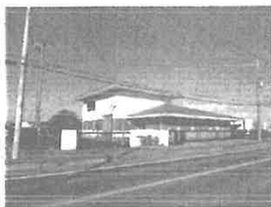
上小目中継ポンプ場
