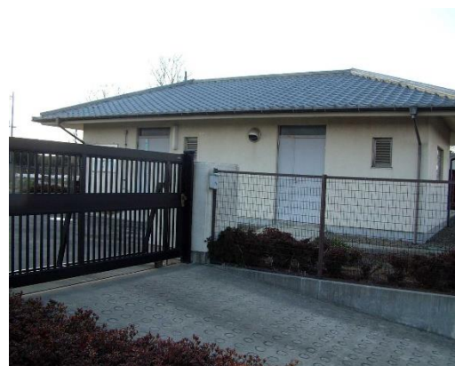
図 4.4.2 上平柳地区農業集落排水処理施設
