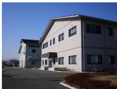
図 4.4.1 小絹水処理センター
