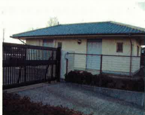
図 4.4.2 上平柳地区農業集落排水処理施設
