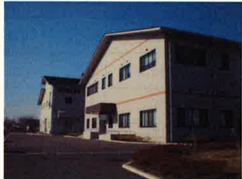
図 4.4.1 小絹水処理センター
